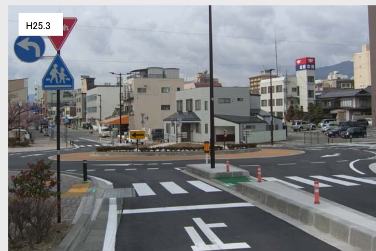
← 交通島の設置により歩行者は2段階横断が可能。さらに流出入車の交錯を防ぐ役割もある。
