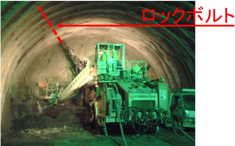
ロックボルトの打設
