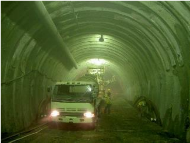
吹付コンクリート
