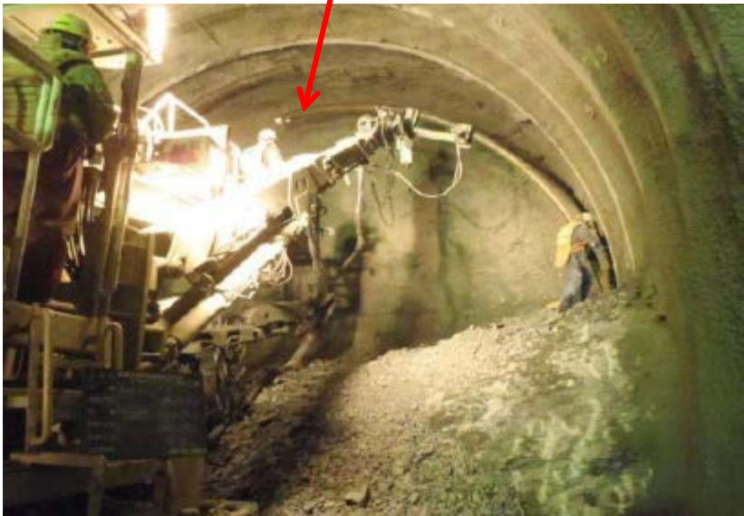
※地山状況により施工を実施
