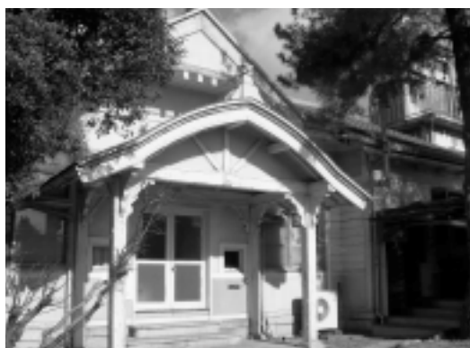
旧飯田測候所（東栄町）
