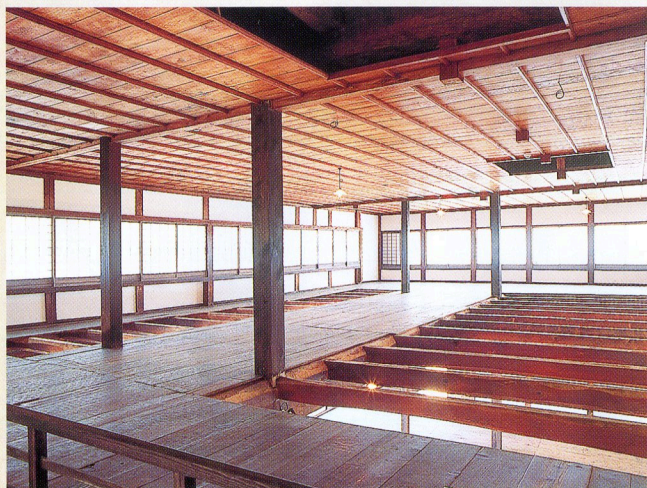
●舞台2階／芝居上演のため、床板と根太の一部が取り外せるようになっています。
